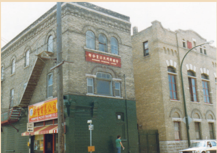
Le pavillon maçonnique chinois
